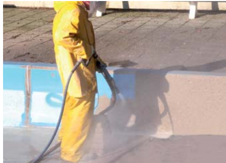
Abb. 2: Abtragen der Farbschicht mit dem torboJET-System
