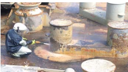
Abb. 9: Rostentfernung mit torbo
