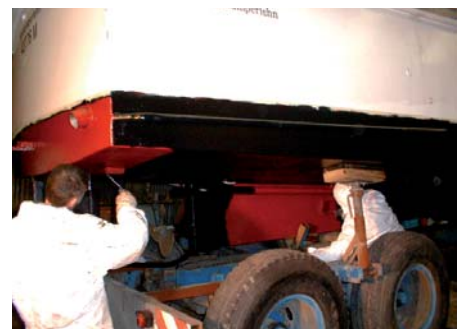
Abb. 6: Auftragen der neuen Beschichtung
