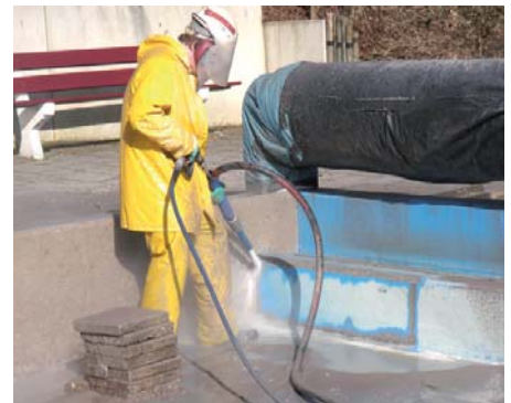
Abb. 3: Arbeiten mit torbo
