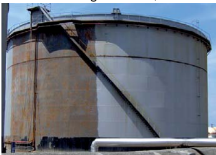
Abb.1: Öltank vorher / nachher
