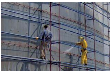
Abb.2: Strahlarbeiten am Tank
