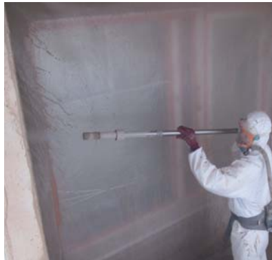
Abb.6: Asbestentfernung mit torbo
