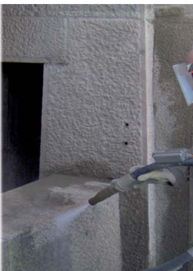
Abb.4: Strahlarbeiten am Monument
