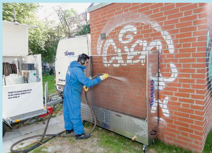
Mittel der Wahl bei der Entfernung ist ein Feuchtsandstrahlverfahren – ohne Zusatz von Chemie. Welches Strahlgut zum Einsatz kommt, ist abhängig von der Oberfläche und deren Verschmutzungsgrad.
